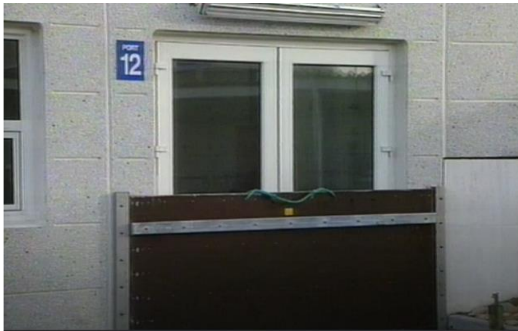
Figur 9 Lokal beredskabstiltag opsat ved varsling af stormflod 10 .
